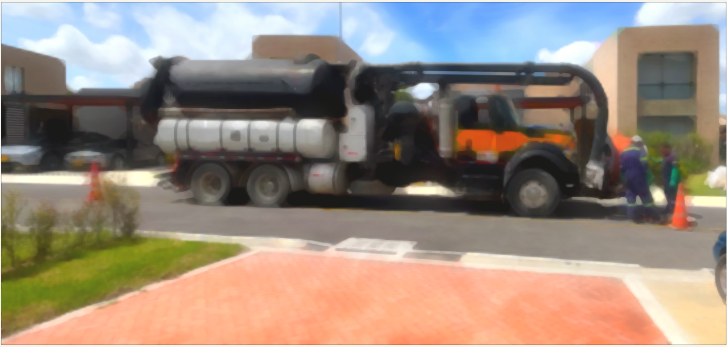
Jornada de succión y limpieza del alcantarillado en el conjunto.
